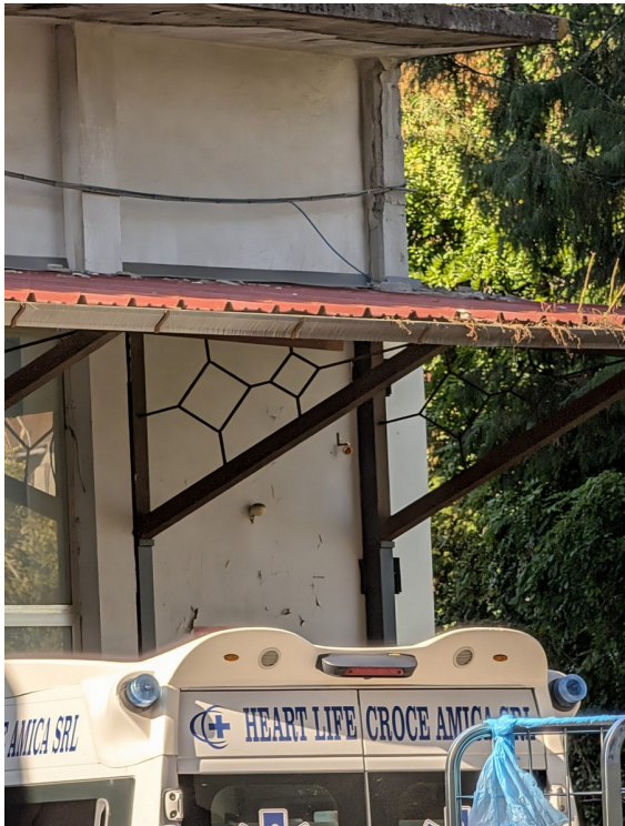
Foto 24 – Prisma P14 – pilastro della pensilina all'estremità destra del fronte.
