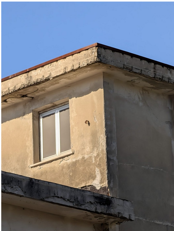
Foto 22 – Prisma P12 – torretta all'estremità destra del fronte, piano secondo, a fianco della finestra.
