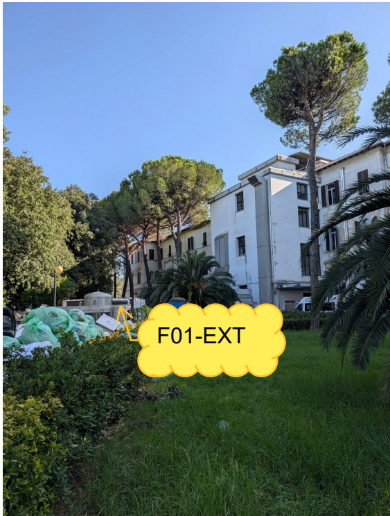
Foto 5 – Percorso lungo il fronte del padiglione 7 verso l'estremità sinistra.
