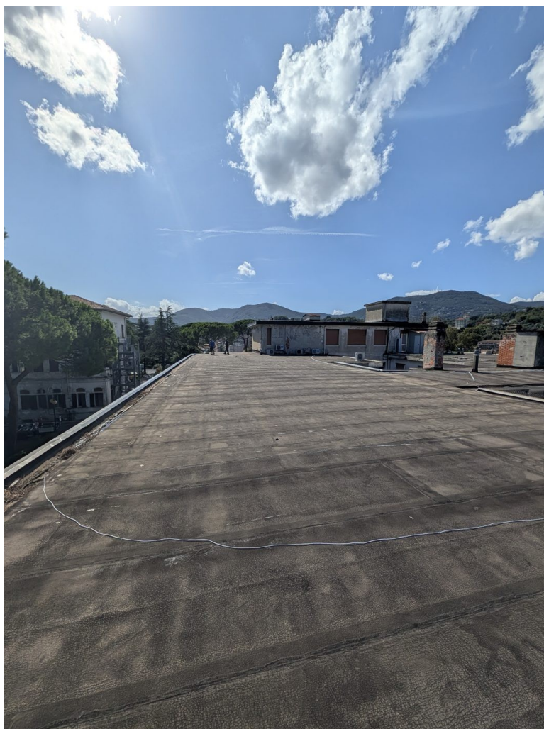
Foto 11 – Copertura piana dell'edificio dei riferimenti: vista d'insieme dei volumi in copertura.
