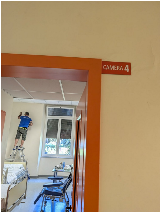
Foto 26 – Camera 4 – accesso alla stanza durante le operazioni di installazione.
