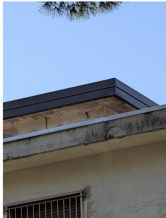
Foto 15 – Prisma P05 – parapetto di copertura in corrispondenza dell'angolo sinistro del fronte.
