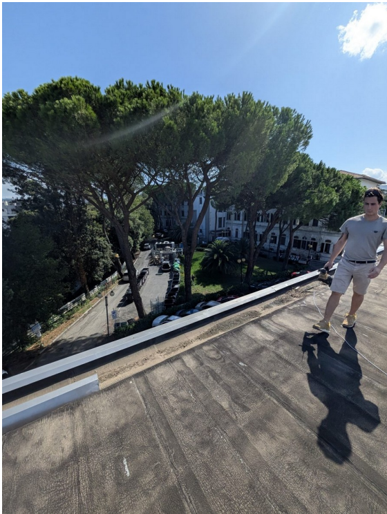
Foto 10 – Copertura piana dell'edificio dei riferimenti: vista verso l'area verde e gli edifici adiacenti.
