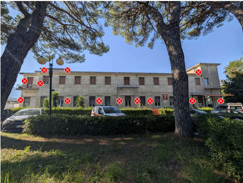
Foto 2 – Padiglione 7, fronte principale: posizione dei prismi ottici di monitoraggio sul fabbricato (piano terra, piano primo e torrette).
