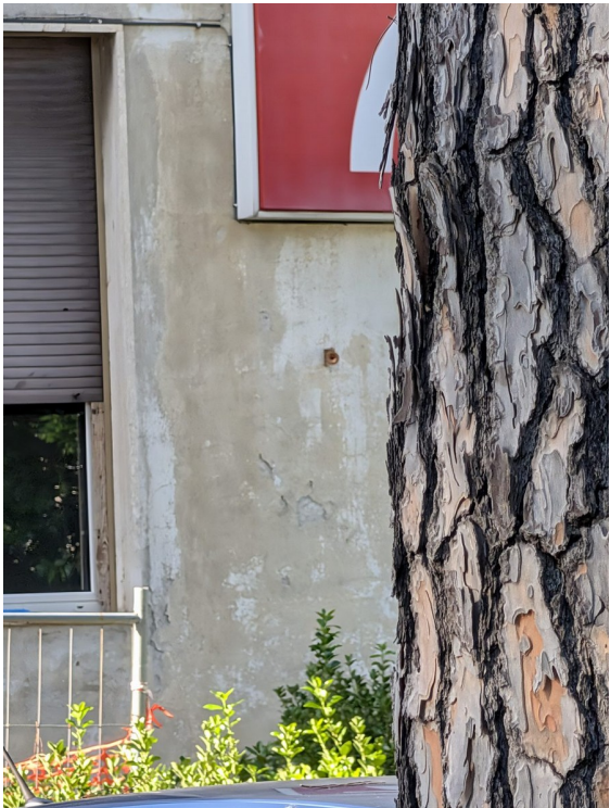
Foto 21 – Prisma P10 – vista d'insieme con la finestra adiacente e la targa "7".
